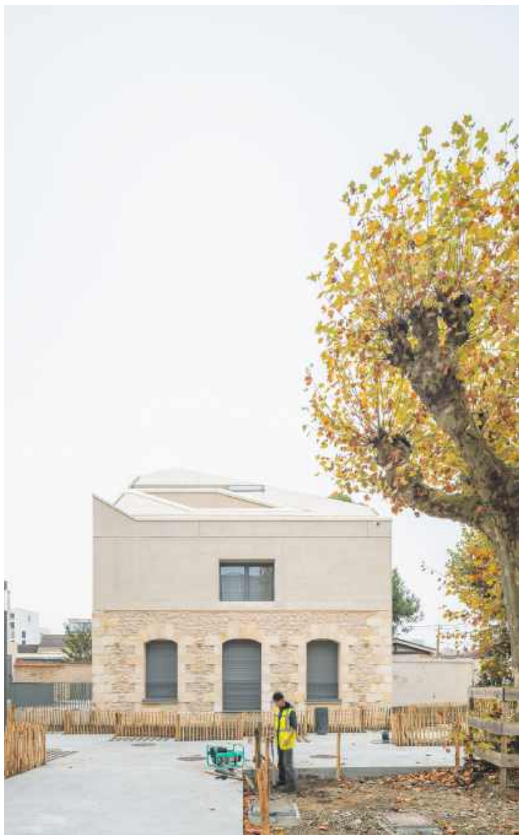
Le site compose avec les traces d'une ancienne caserne militaire dont subsistent des murs d'enceinte en pierre massive.
