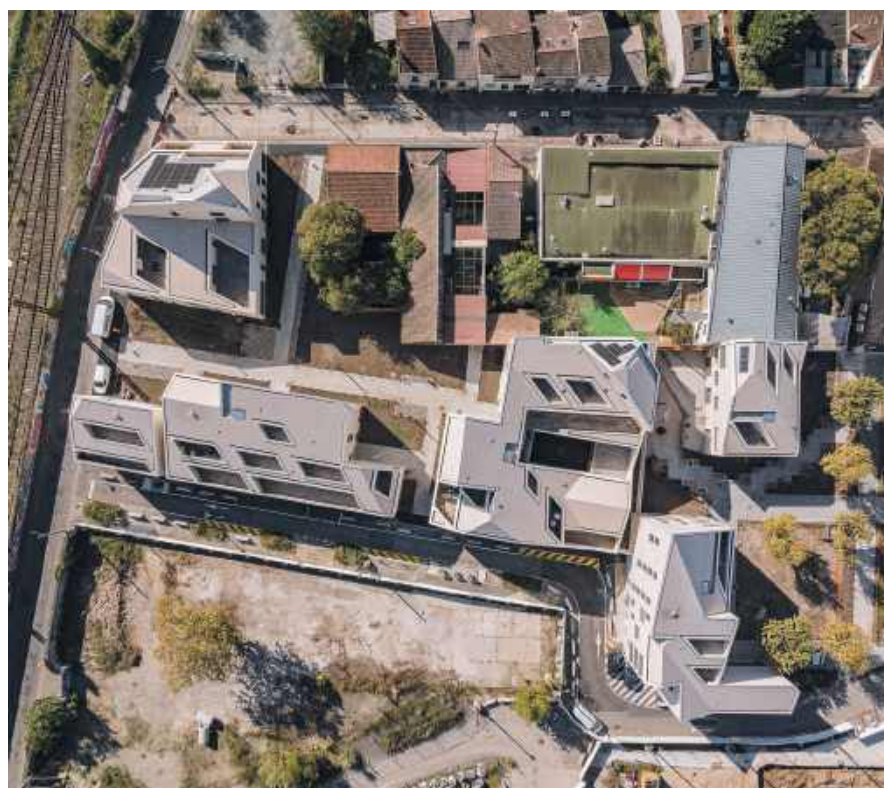
Le site a conservé les murs d'enceinte en pierres massives de l'ancienne caserne.
